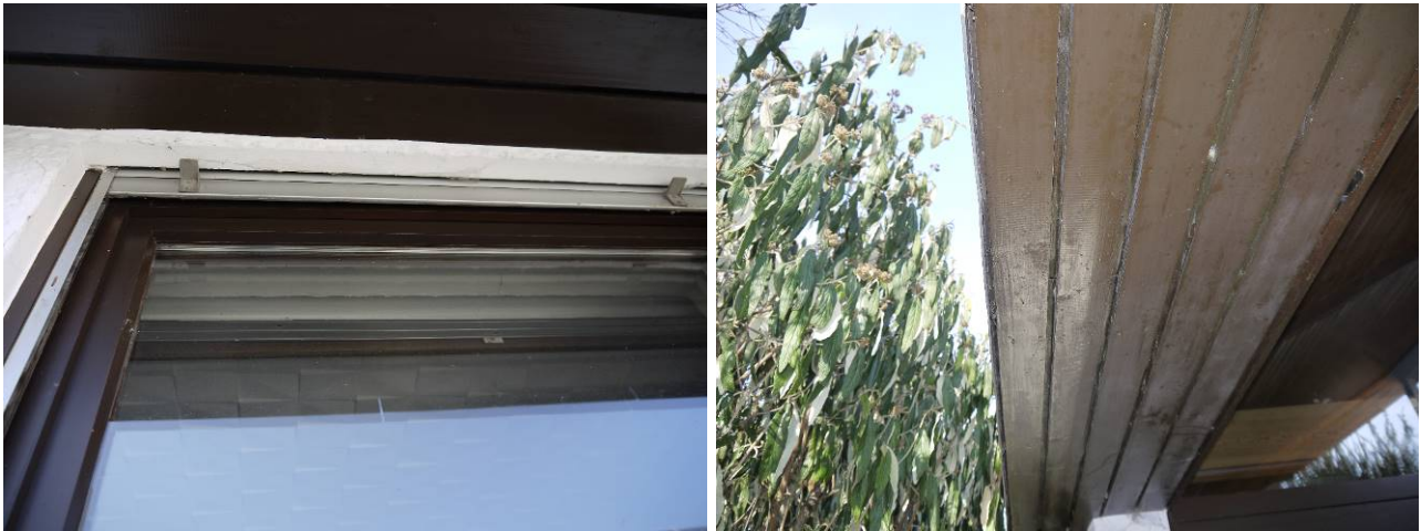
Abb. 14: Linkes Bild: Rollladenkasten mit potenzieller Spalte. Rechtes Bild: Dachüberstand ohne Spalten.
