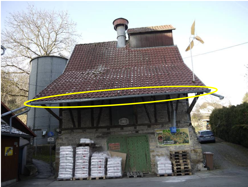
Abb. 4: Spalten an den Dachziegeln der Traufseite.
